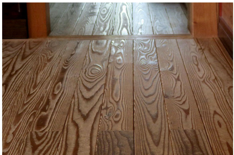
8年経過したスギ製床板 (見事な浮造り)
