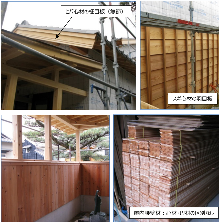
写真 3.3 伝統的工法で建築中の民家の例
