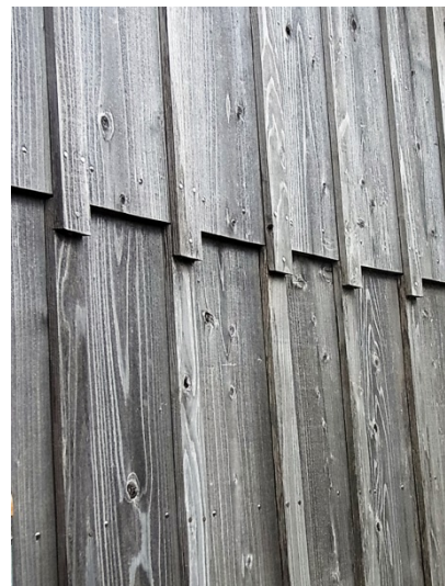
縦板張り・目板押さえの外壁
