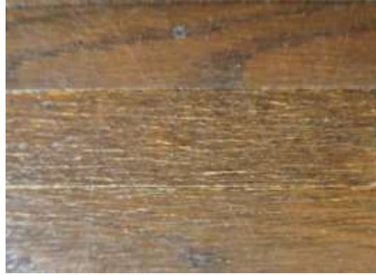
○ 掃出し窓付近の複合床板の変状（表層の化粧突板の干割れと部分剥離：18年経過）
