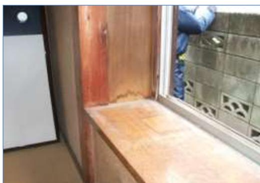
○ 窓枠に発生した雨染み（室内側）
