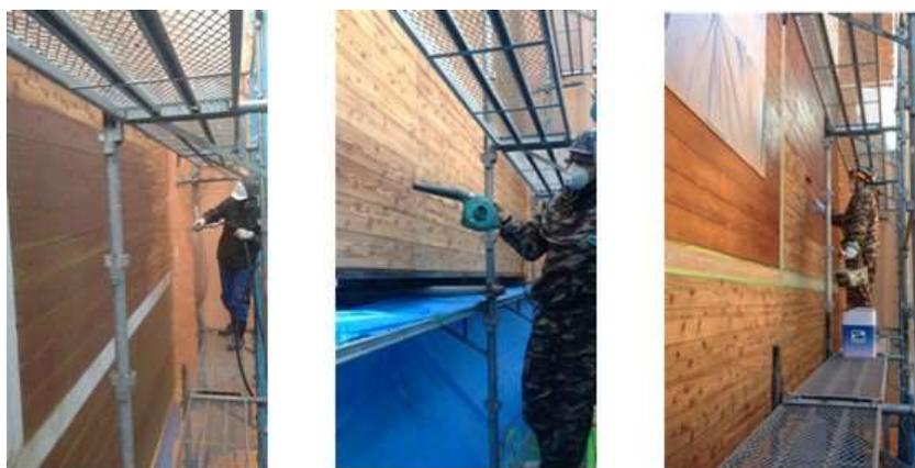
写真 4.2 造膜形塗装の塗り替え例：植物種子殻メディアブラスト法（乾式）により既存塗膜を除去（左）、粉末除去（中）、造膜形の木材保護塗料塗り（右）を実施している様子
