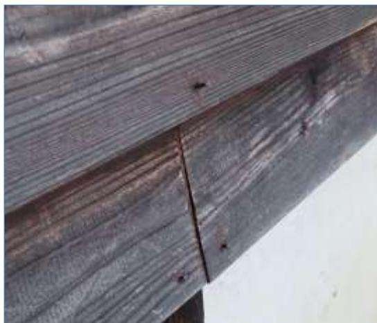
○ 乾湿繰り返しによる板目材の幅反りとそれに伴う釘の引き抜け
