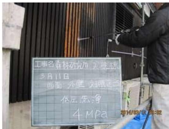
写真 3.8 高圧水洗浄法による既存塗膜の剥離工程
