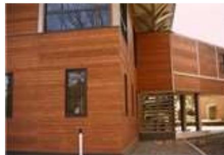
写真 3.5 半透明仕上げ（含浸型）
