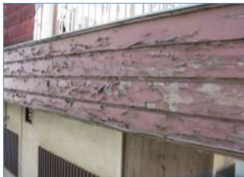
○ 造膜型塗装の剥離脱落
