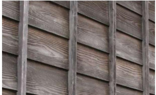
ささら子状の押し縁による下見板の固定
