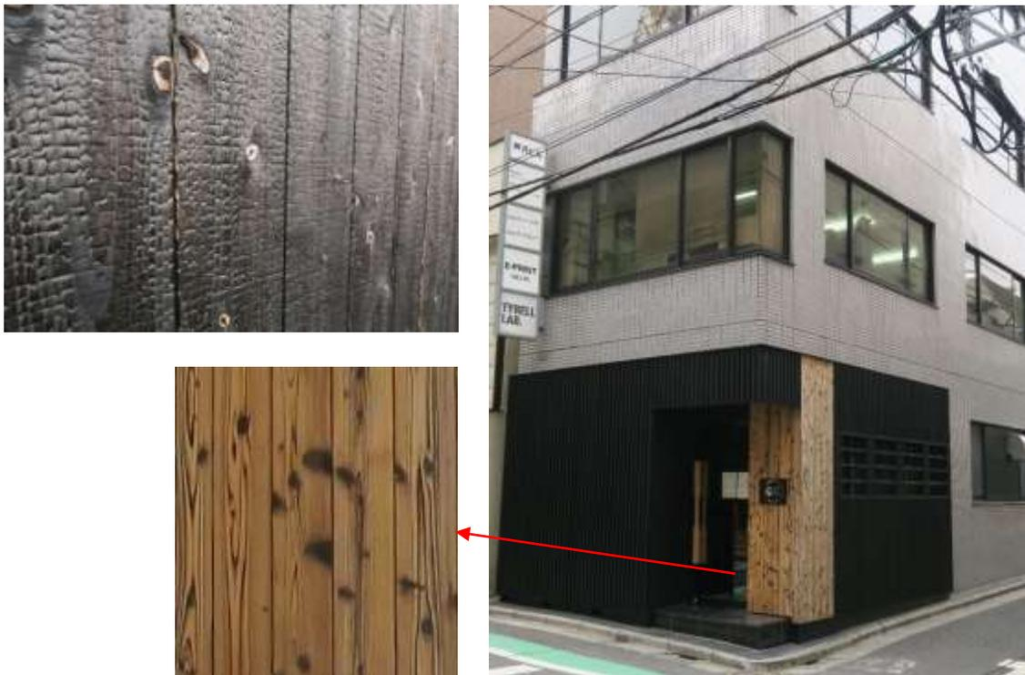
写真 3.2 焼きスギとその応用製品（建物の化粧材として使用）
