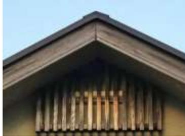
破風の痒に発生した隙間（対策しない場合）
