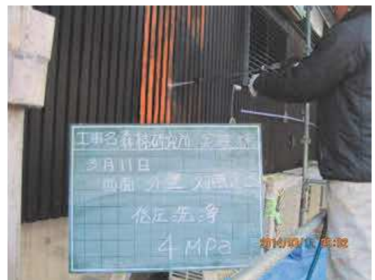
写真 3.8 高圧水洗浄法による既存塗膜の剥離工程 （この例では材面保護のため比較的低压に設定）
