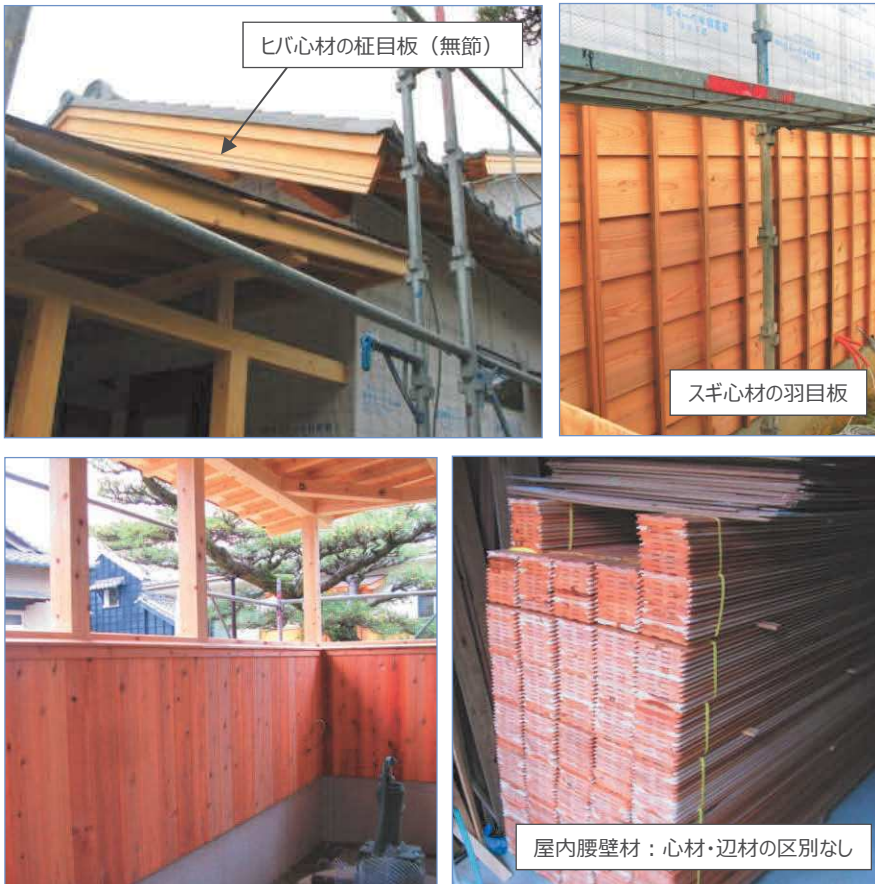
写真 3.3 伝統的工法で建築中の民家の例
