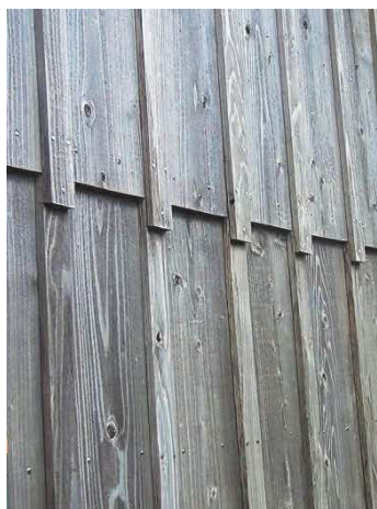
継ぎ合わせ部は目違いとし、上部側の壁面を出す
