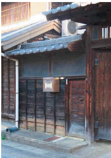
写真 1.17 外壁地際部の変色
