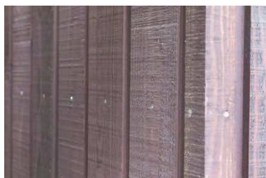
ラフソーンに黒灰色系の塗装仕上げとした例
