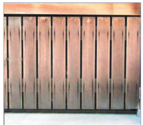
写真 1.13 板塀固定金具による鉄汚染
