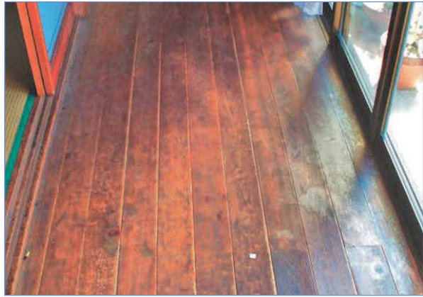
写真 1.6 ヒノキ縁甲板の幅反り（窓際で顕著）
