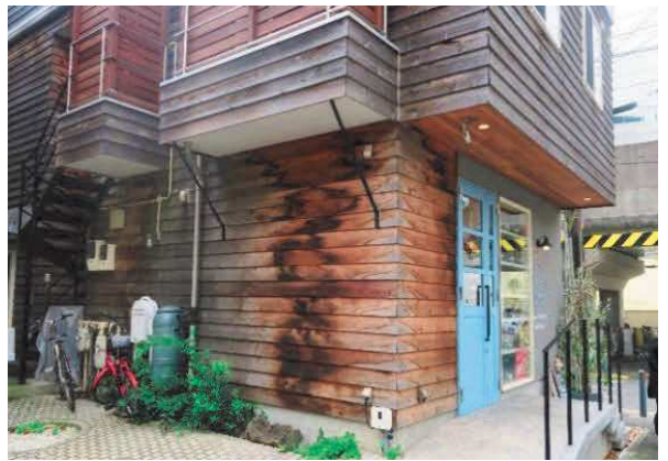
写真 1.15 南京下見板（ベイスギ無塗装）の雨染み
