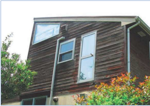
写真 1.5 下見板の幅反り及び縦反り
