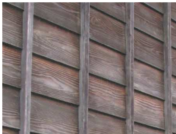
ささらこ状の押し縁による下見板の固定
