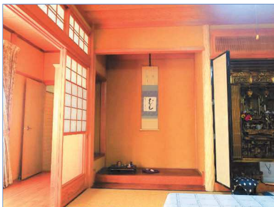
写真 1.25 30年経過した屋内の様子（真壁造住宅）
