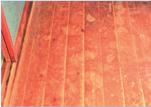
写真 1.21 縁甲板の生活汚染（25年経過）
