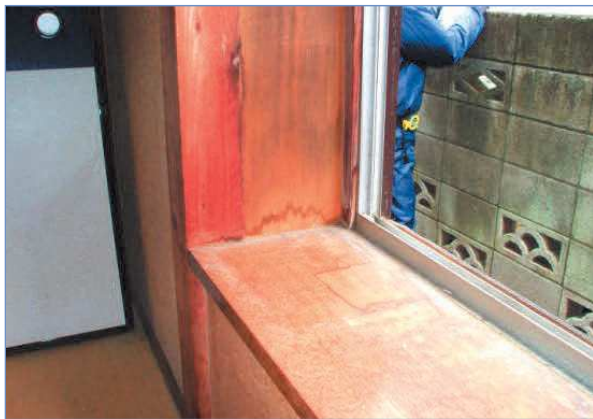
写真 1.14 窓枠に発生した雨染み（室内側）
