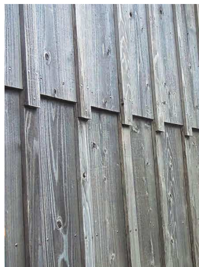
縦板張り・目板押さえの外壁
