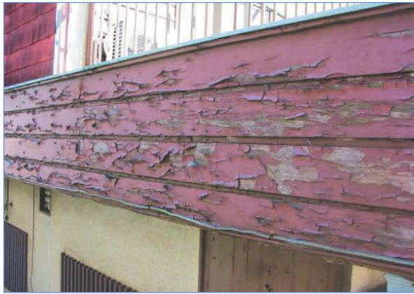
写真 1.10 造膜形塗装の塗膜剥離
