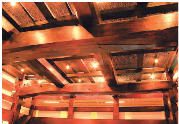
写真 1.4 架構美の一例（民家）
