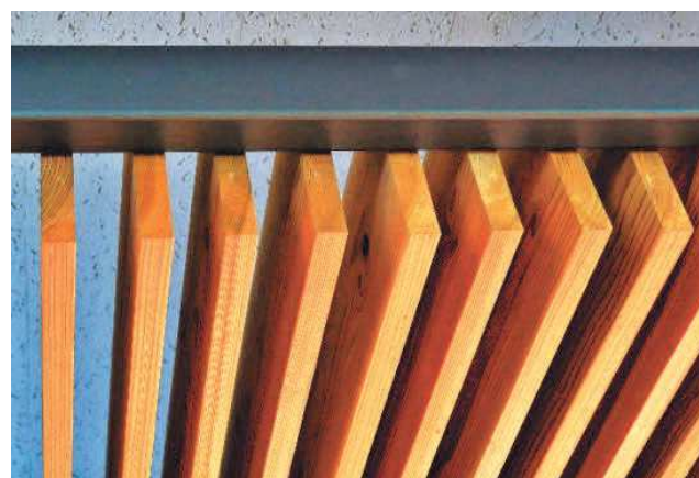
宮崎空港・保安検査場
