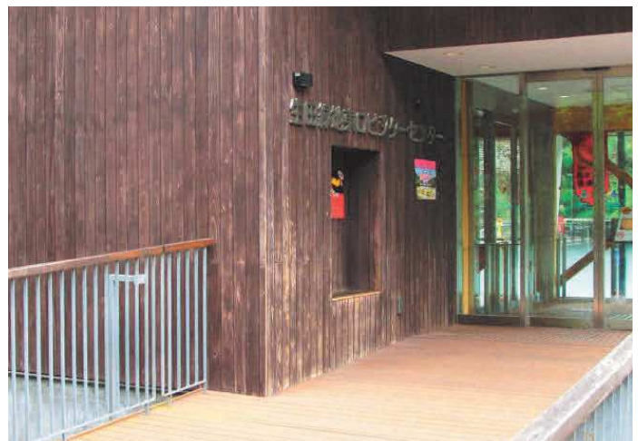
写真 1.23 歩行者の通行による塗装壁面の摩耗
