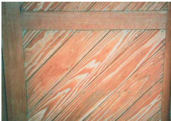
写真 1.12 含浸形塗装の色抜け
