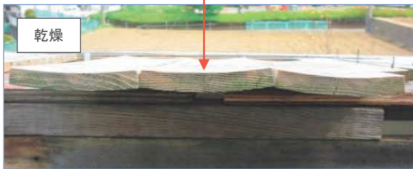
写真 1.7 乾湿繰り返しによる板目材の幅反りとそれに伴う釘の引き抜け
