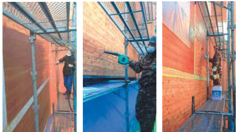
写真 4.2 造膜形塗装の塗り替え例：植物種子殻メディアブラスト法（乾式）
