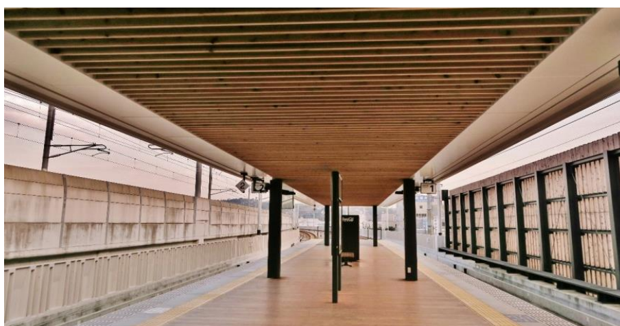
駅舎の木装化 (JR九州・上熊本駅)：新規開発の木質建材を用いて高耐久化
