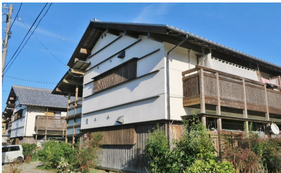
高知県・佐川町町営住宅： 伝統技術を生かし使用材料も吟味。16.5 年経過した今も健全
