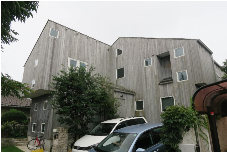
フラットな壁面構成とシルバー系保護塗装による色彩ムラの発生抑制（神奈川県藤沢市）
