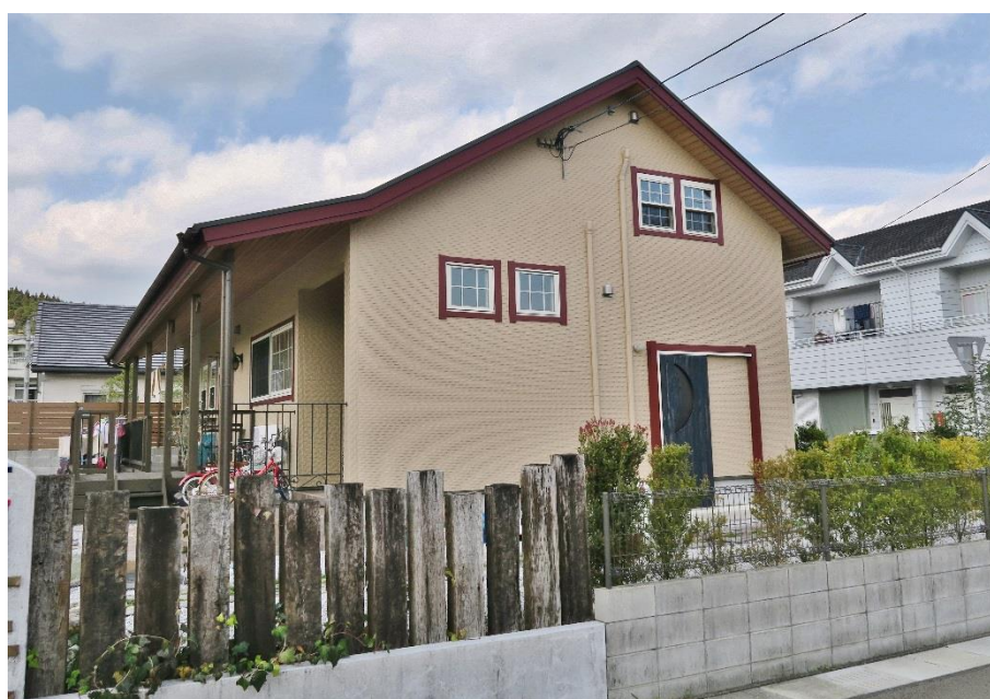
折れ屋根にして庇を伸ばし、その下部空間を有効活用。とくに雨天時に有効(宮崎県日南市)
